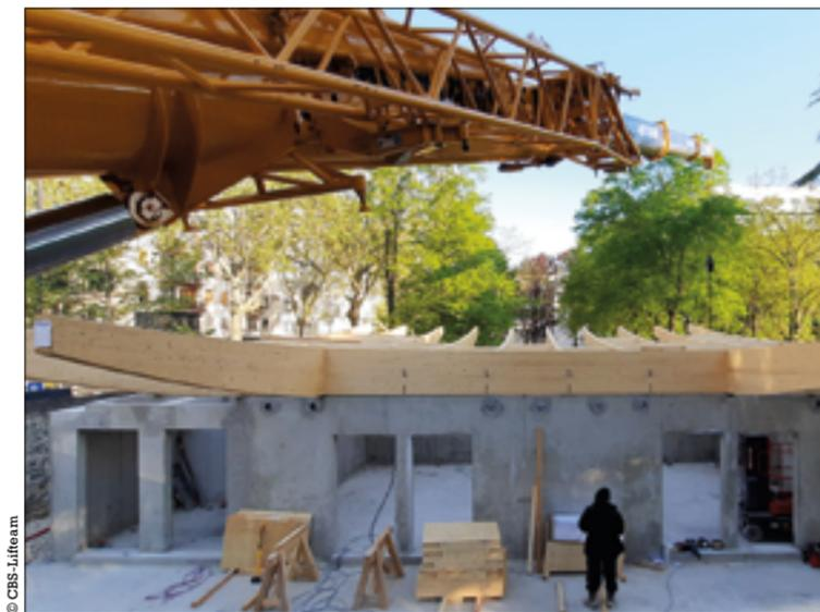
pouvoir suspendre les poutres d'angle du porte-à-faux et relier l'ensemble, un profil HEB 320 a été apposé sur le pourtour des poutres principales. Puis un panneau bois triplis d'habillage a été posé sous ce profilé acier – contenu dans l'épaisseur de l'isolation du toit – pour le dissimuler. Sur les panneaux en bois couvrant le toit, l'étanchéité de l'édifice a été alors réalisée, par la pose d'un pare-vapeur et d'une membrane PVC.
