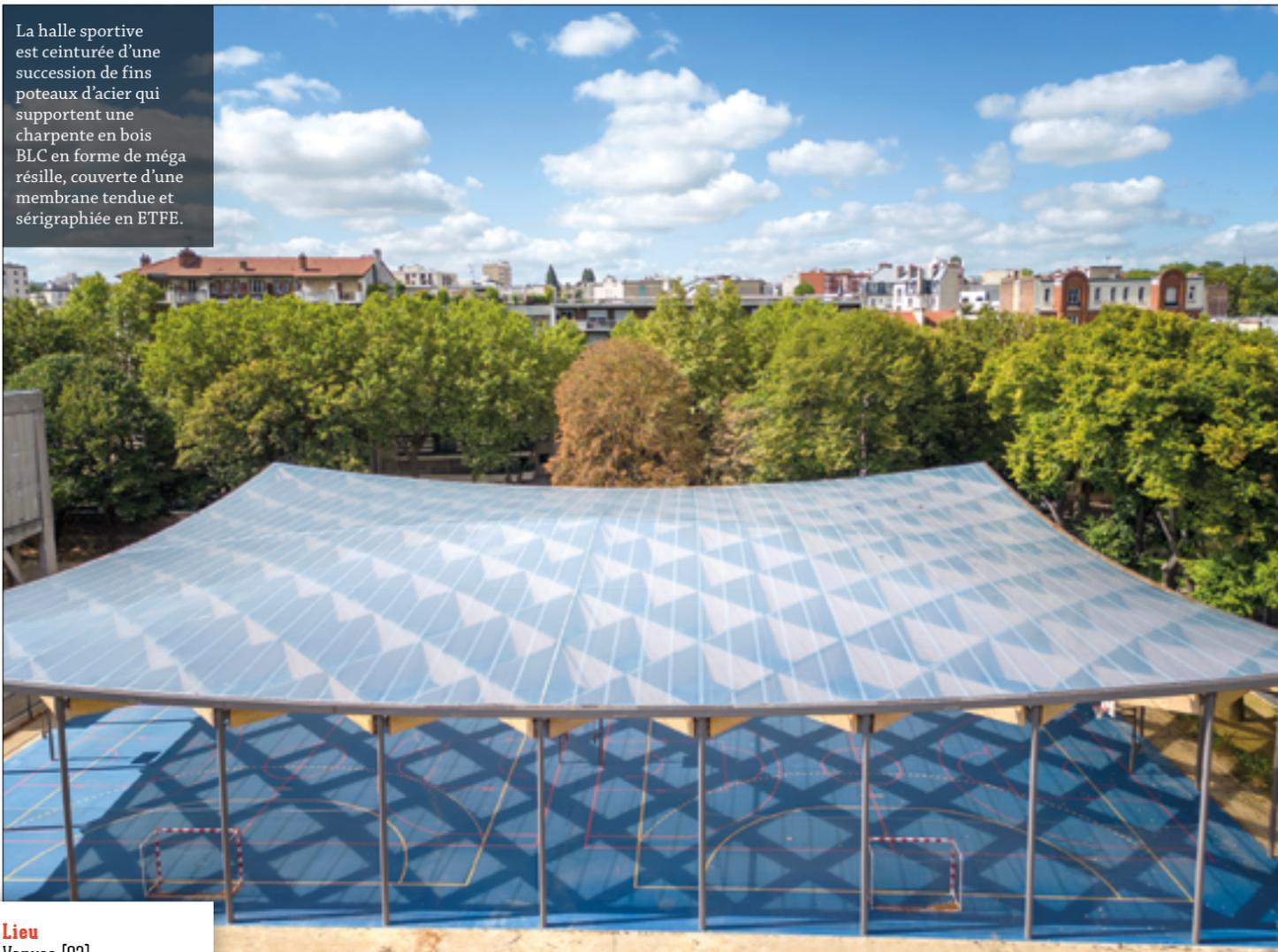
La halle sportive est ceinturée d'une succession de fins poteaux d'acier qui supportent une charpente en bois BLC en forme de méga résille, couverte d'une membrane tendue et sérigraphiée en ETFE.
